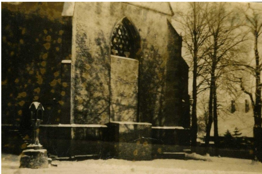
Die vielfältigen Schwierigkeiten und Gefahren der Zeit symbolisiert der „Splitterschutz“ an der „Brauttür“ der Schildescher Stiftskirche im Winter 1940. Fotos: Sammlung Wibbing
