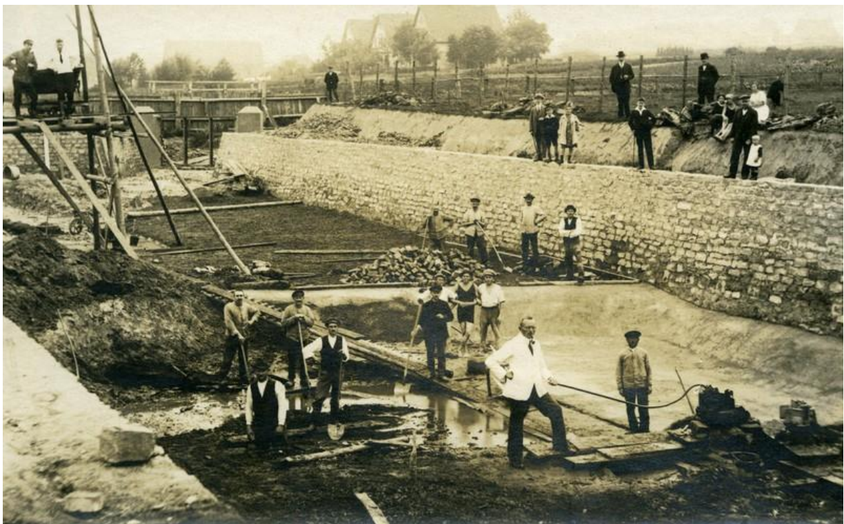
Bau der Becken für das Schildescher Freibad 1913
