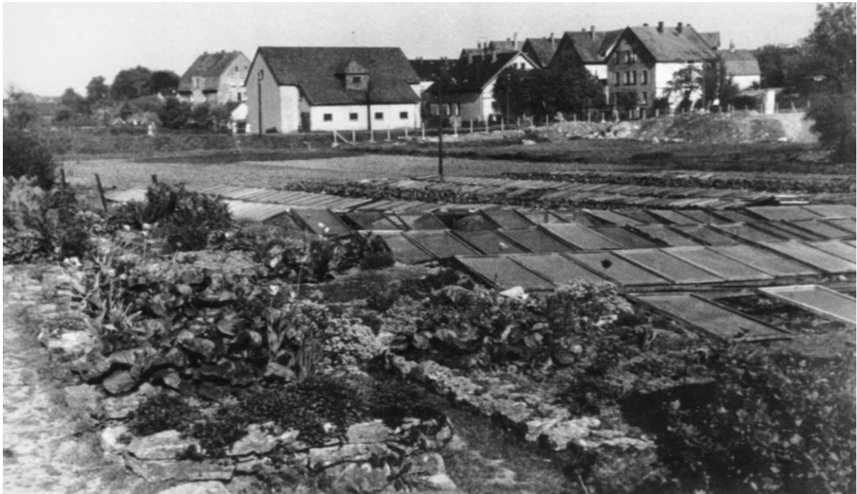
In der Bildmitte ist der ehemalige Eiskeller am Brodhagen zu erkennen, links die Eiswiese.
