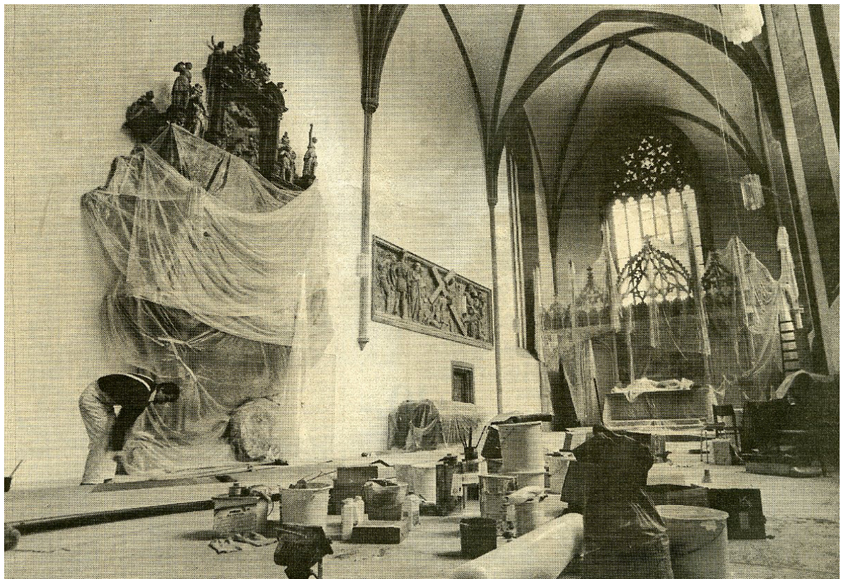
Seit Anfang Februar sind die Handwerker damit beschäftigt, die Neustädter Marienkirche innen „aufzufrischen“. Bis zum Konfirmationsgottesdienst am 25. April wollen sie fertig sein. (Foto: van Zütphen)
