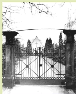
Die Kapelle auf dem Schildescher Friedhof wurde 1930 errichtet und ermöglicht seitdem eine würdevolle Verabschiedung der Toten direkt am Ort. Der Blick fällt hier auf das alte Eingangstor und führt den Hauptweg entlang zur Kapelle, die mittlerweile wegen ihres markanten Baustils unter Denkmalschutz steht. Foto: Umweltbetrieb Stadt Bielefeld
