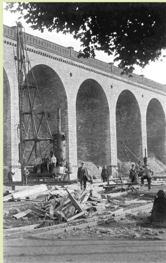
Der stetig wachsende Bahnverkehr forderte 1917 einen Ausbau der Strecke auf vier Gleise. Damit war natürlich auch eine zweite Brücke erforderlich. Wegen des weichen Untergrundes mussten Dampframmen – wie hier auf dem Foto zu sehen – etliche hundert Holzpfähle in den Boden einlassen. Der Viadukt selbst zeigte sogar als reiner Funktionsbau noch gewisse künstlerische Anklänge, wenn man die Gesimse am oberen Rand beachtet. Foto: Stadtarchiv Bielefeld
