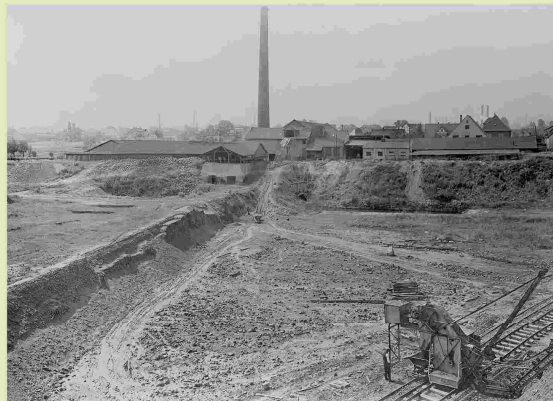
In direkter Nachbarschaft zu Bracksieks Windmühle entstand 1896 die Ziegelei Bracksiek. Die stetig wachsende Bevölkerung benötigte Wohnhäuser und damit Backsteine. Deshalb fanden sich Ziegeleien seiner Zeit oft in der Nähe von Baugebieten, auch um die Transportkosten niedrig zu halten. Aus der angrenzenden Kuhle, die heute einen Teich beheimatet und auf dem Foto im Vordergrund zu erkennen ist, wurde der Ton zu Backsteinen verarbeitet, zeitweise sogar im Feldbrand. Die Ziegelei Bracksiek – auf dem Foto im Hintergrund - wurde 1985 abgerissen. Foto: Sammlung von Hollen
