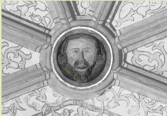
Die wichtigsten Bauelemente stellen in einer Kirche stets die Schlusssteine dar. Sie vollendeten die Gewölbe und damit den Kirchenbau. Dies gilt auch für die Stiftskirche in Schildesche. Nicht verwunderlich ist es daher, dass diese Steine besondere religiöse Motive aufwiesen. Einer der Schlusssteine und zwar der im Chorraum zeigt den Kopf des Täufers auf der sogenannten Johannesschüssel. Nach dem biblischen Bericht wurde Johannes auf Wunsch der Salome und auf Veranlassung des Königs Herodes geköpft und auf einer Schüssel präsentiert. Foto: Evangelisch-luth. Stiftskirchengemeinde
