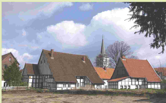
Das moderne Foto zeigt einen Blick auf die Klusmann-Stätte mit der Stiftskirche im Hintergrund. Der Kirchturm ist aufgrund von Reparaturarbeiten eingerüstet. Foto: Klaus-Dieter Kuhnert
