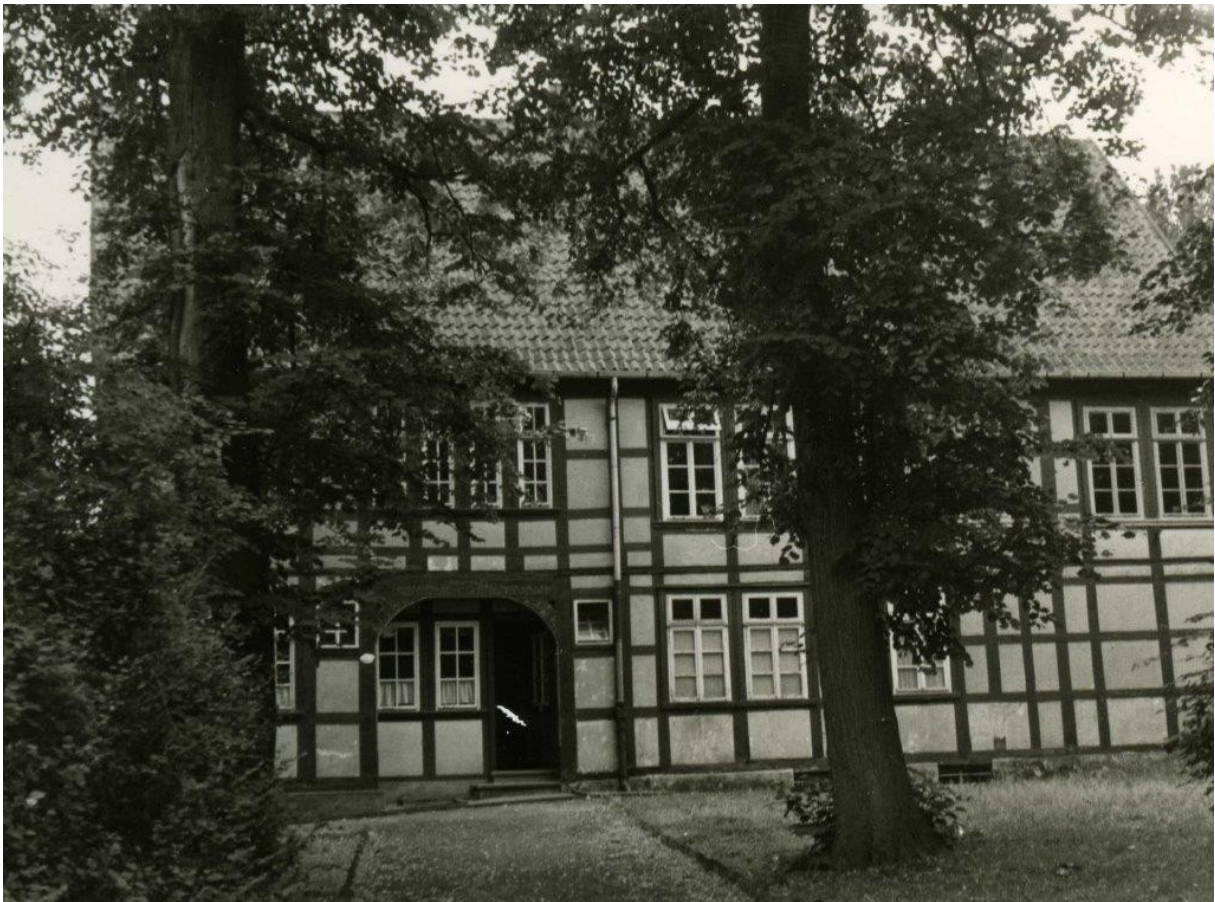
Außenansicht von der Traufseite um 1960: rechts befand sich der Wohntrakt, links ein landwirtschaftlich genutzter Teil. Foto: Sammlung Wibbing
