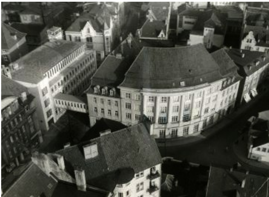
Luftbild des Volkswacht-Gebäudes mit dem neuen Druckhaus aus dem Jahr 1953. Foto: Stadtarchiv Bielefeld
