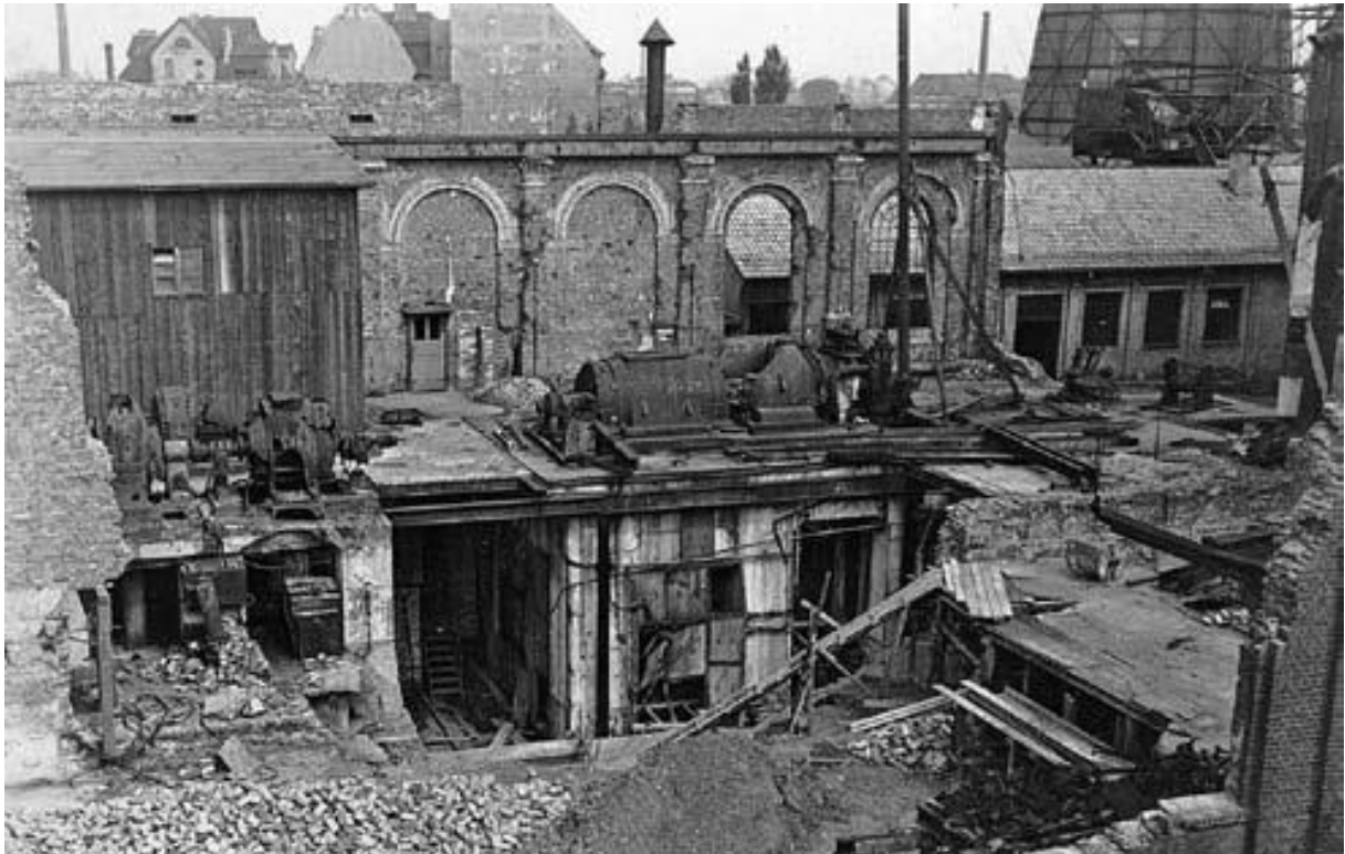
Nachdem sich der Rauch verzogen hatte, zeigte sich die ganze Zerstörung des Gleichstromwerkes an der Schildescher Straße.
