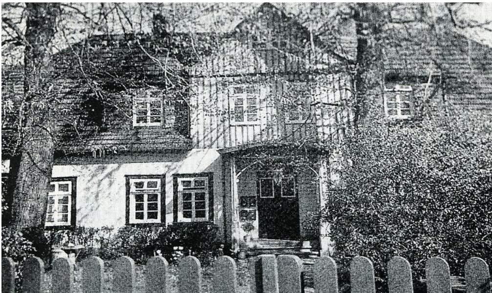
Die Äbtissinnenkurie in Schildesche: sie dokumentiert als letzter, einzig erhaltener Stiftshof die Geschichte des Damenstiftes. Nach der Aufhebung gelangte sie in den Besitz eines Apothekers, wurde deshalb lange Zeit im Volksmund auch als „Alte Apotheke“ bezeichnet.
