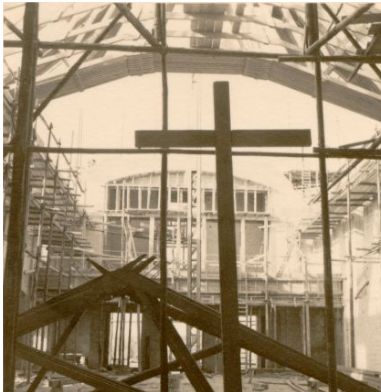
Der Rohbau der Christkönigkirche schreitet voran (1954).
